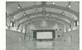
体育館の屋根(天井)部分のアーチフレームに使用
